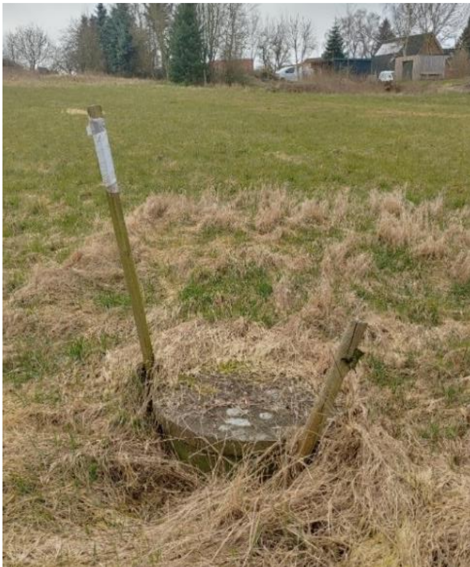
Abb. 2.4 Feuchtere Senke im westlichen Teil des Plangeltungsbereiches mit zentralem Regenwasserschacht (Fotos: A. Maier, 15.03.22).
